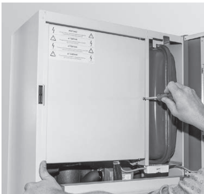
Fig. 17 Verkleidungstür öffnen und Schraube entfernen
