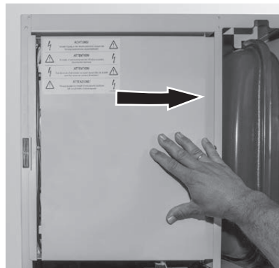
Fig. 18 Abdeckung nach rechts schieben und abnehmen
