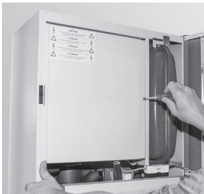
Fig. 17 Verkleidungstür öffnen und Schraube entfernen
